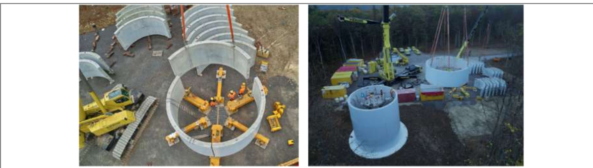
Abbildung 6 Turm des Typs TCS164, Errichtung des Keystones (links) und der Sektion (rechts)
