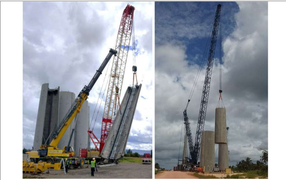
Abbildung 5 Vormontage (links) und Montage (rechts) von Turmsektionen aus Beton vom Typ TCS179-00 und TCS199-00
