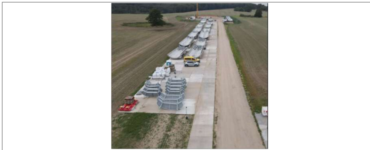
Abbildung 46 Bsp. Lagerung der Betonsektionen am Standort für den TCS179
